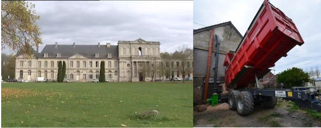
Figure 2 : Chaudière miscanthus à l'Abbaye d'Ourscamp
